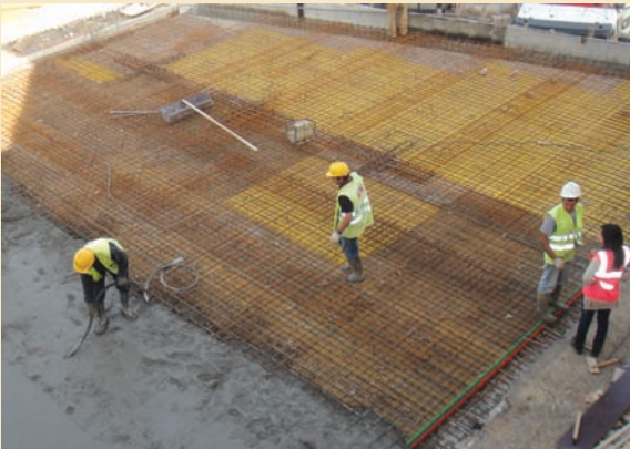
► EcoPolis: Regenerar Humanizar – Pormenores da execução da laje ao lado do edifício da Câmara Municipal, para construção de sanitários públicos e gabinetes
