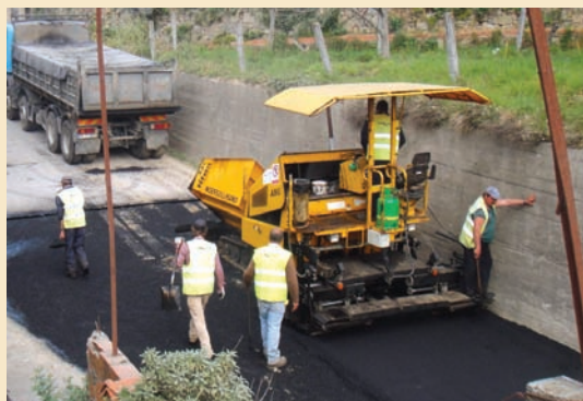
► Pavimentação de um troço da estrada de Nogueira, após intervenção na conduta de águas pluviais
