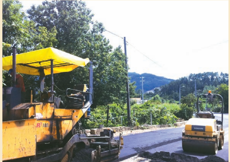
► Pavimentação em tapete betuminoso a quente do Caminho da Associação em Couto de Esteves
