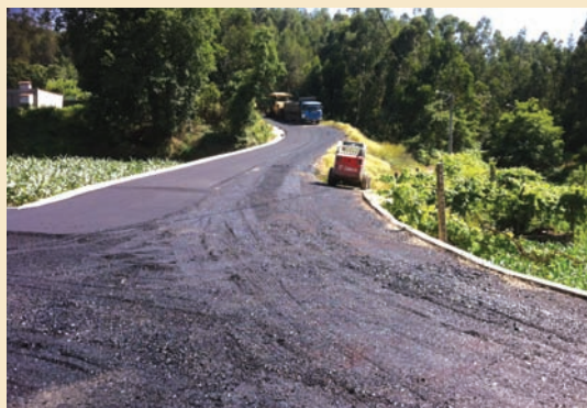
► Pavimentação do caminho da Redouça, na freguesia de Cedrím. Curva após retificação do traçado
