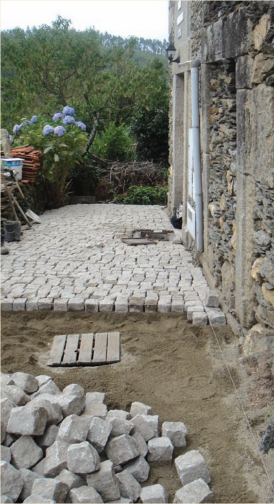
► Pavimentação em calçada de cubos do Caminho do Marmeleiro, no lugar da Macida, freguesia de Talhadas
