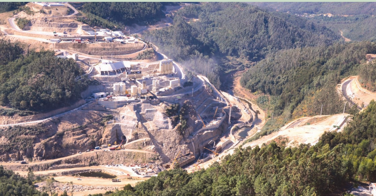
► Barragem do Couto (Vilarinho), em construção
