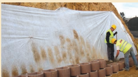
► EcoPolis: Regenerar Humanizar – Requalificação da Avenida Augusto Martins Pereira – Revestimento de talude com floreiras
