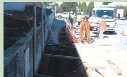
▶ Trabalhos em curso. Instalação de cabo subterrâneo
