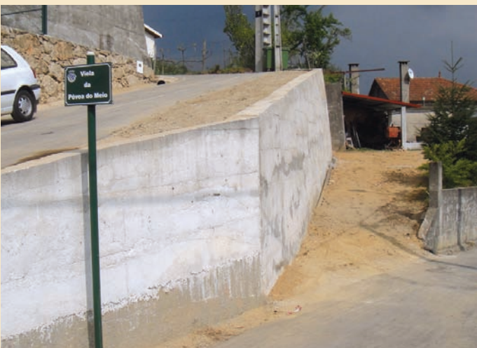
▶ Construção de muro de suporte ao caminho no lugar das Póvoas na intersecção com a Viela da Póvoa do Meio
