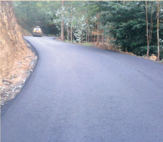
▶ Pavimentação da estrada da Granja, com ligação à E.M. 569 (Ribeirada)
