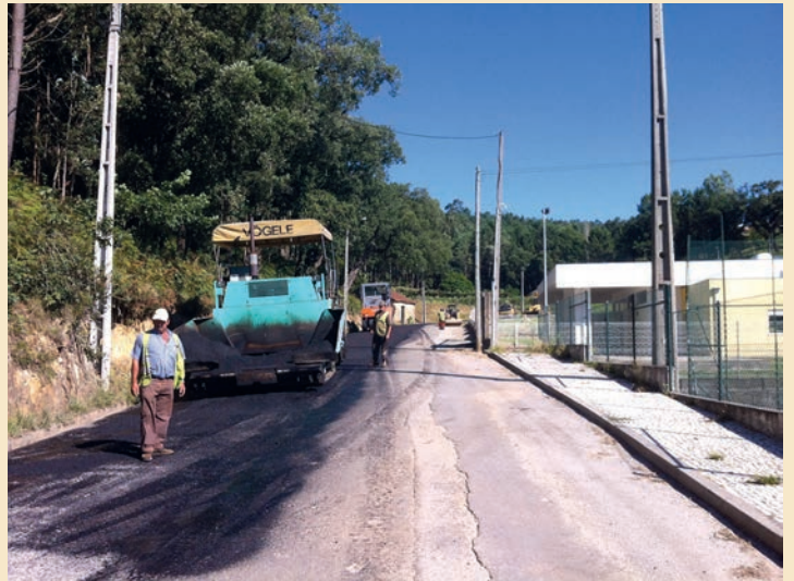
Pavimentação da Rua da Igreja à Junta de Freguesia, Silva Escura
