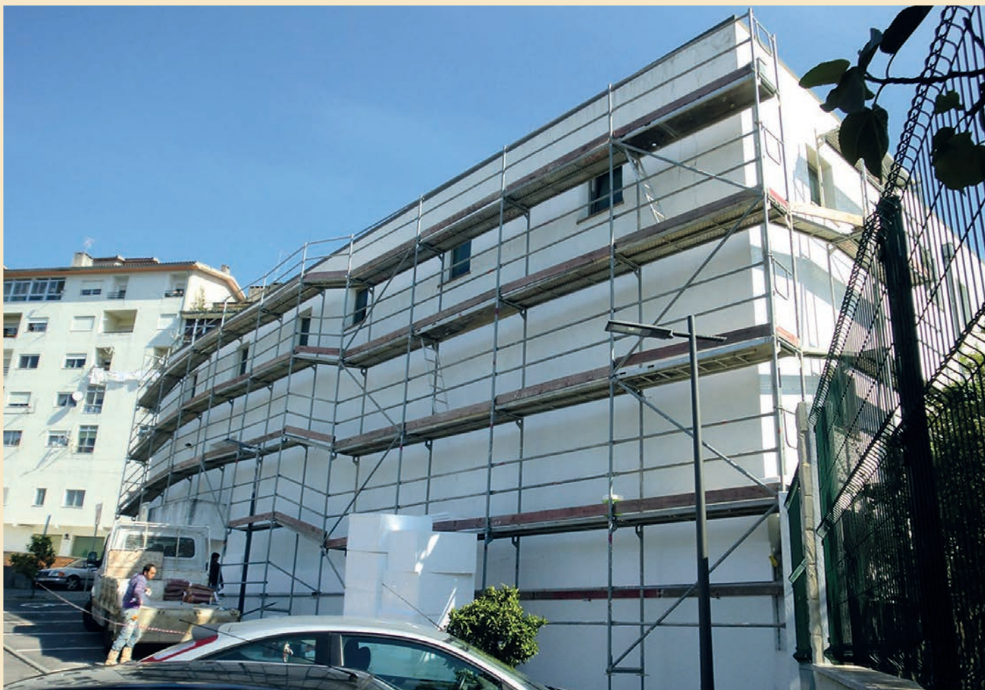
Execução de revestimento exterior, tipo capô, com esferovite de alta densidade CAE – Centro de Artes e Espectáculos de Sever do Vouga
