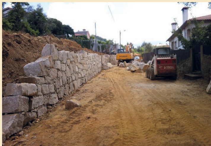
Alargamento/Construção de muros em pedra Rua da Calçada – Talhadas
