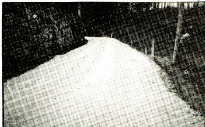
Pavimentação do Caminho da Tamanqueira em Penouços.
