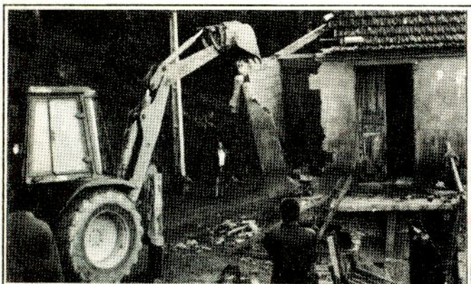
Covêlo — Demolição parcial de casa para alargamento da estrada em construção. Um agradecimento ao proprietário por ter cedido parte da casa gratuitamente.
