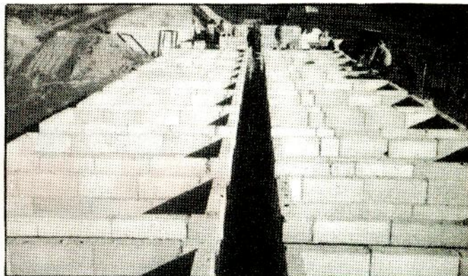
Cemitério de Rocas — A empresa construtora tem colaborado na boa execução da empreitada, quer ao nível de alterações pontuais, quer quanto ao ritmo excelente dos trabalhos, quer quanto aos serviços pedidos pela Junta de Freguesia de Rocas.
