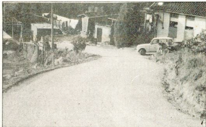
Teca (Paradela). A Junta de Freguesia de Paradela apesar das suas grandes dificuldades financeiras não se tem ficado pela realização de pequenas obras. Pelo contrário para além do abastecimento de água à freguesia mandou, recentemente, reparar e pavimentar o caminho do lugar da Teca, na foto.
