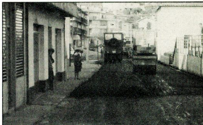
Colocação de tapete betuminoso em arruamentos da vila.
