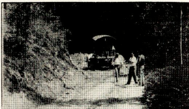
Varziela (Cedrim) - Início de trabalhos de rectificação e pavimentação.
