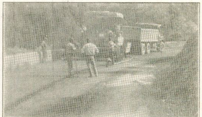
EN 16 - Colocação de tapete betuminoso.
