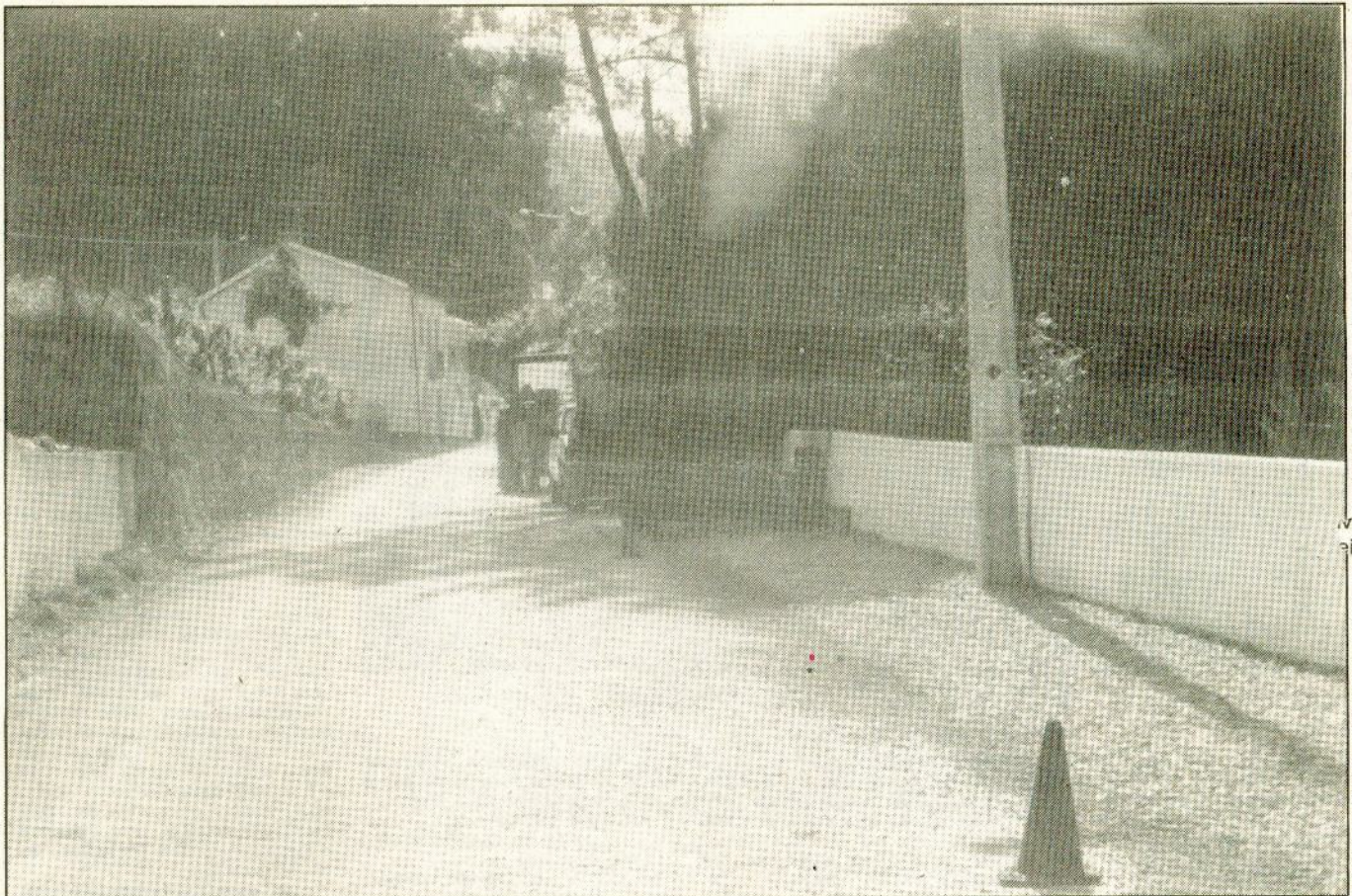
Reparação da estrada que dá acesso a Silva Escura.
