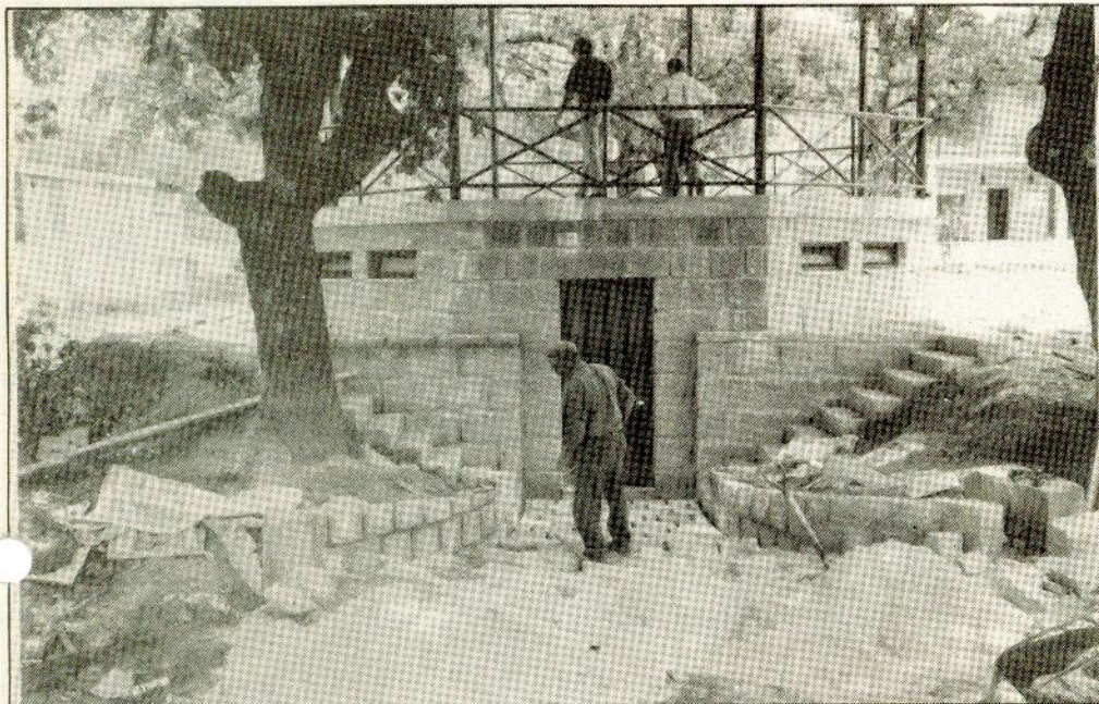
Sanitários — Talhadas. As obras estão quase concluídas.
