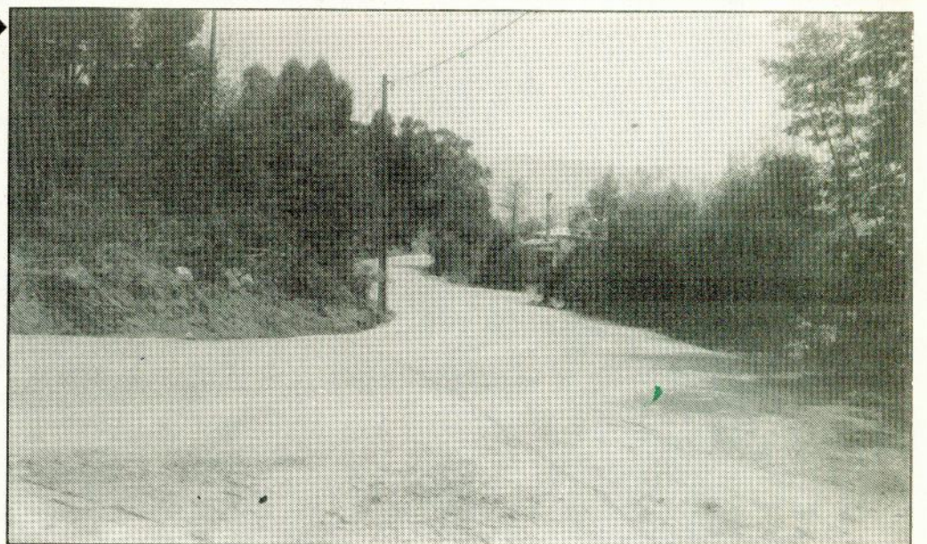
Sanfins (Cooperativa). Pavimentação.
