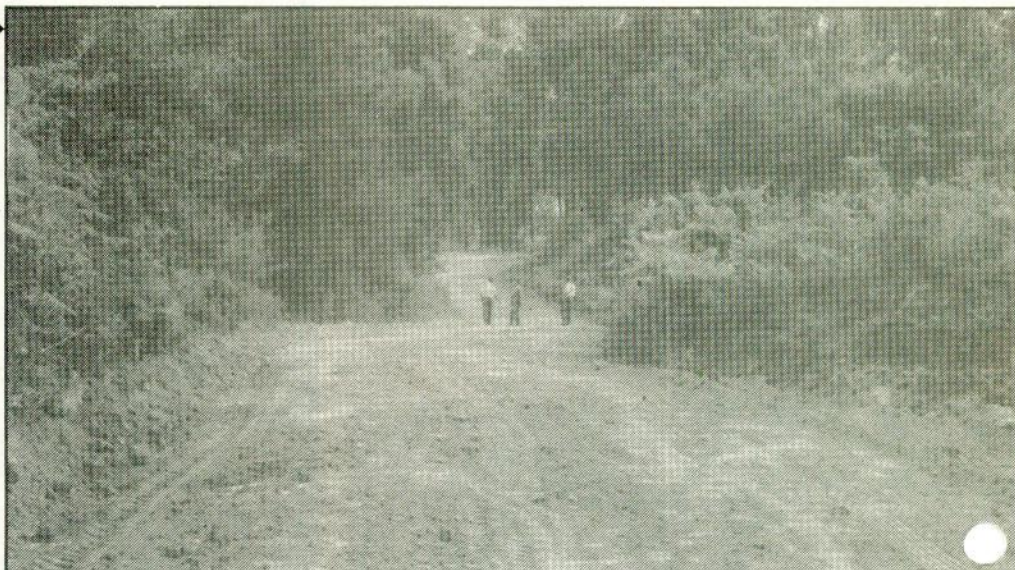
Caminho de Sanfins a Irijó (terraplanagens).
