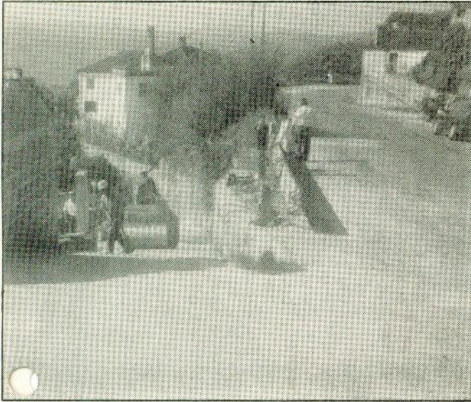
Lomba (Pessegueiro). Abertura de acesso que dá para o Cruzeiro.
