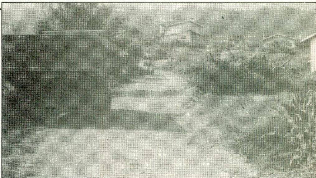
Abertura e rectificação do Caminho de Sanfins a Irijó (Rocas).
