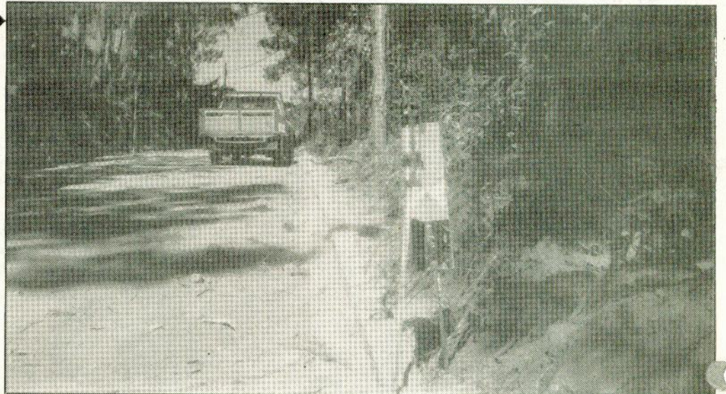
Borrçalhal ao Tendal do Linho. Início dos trabalhos.
