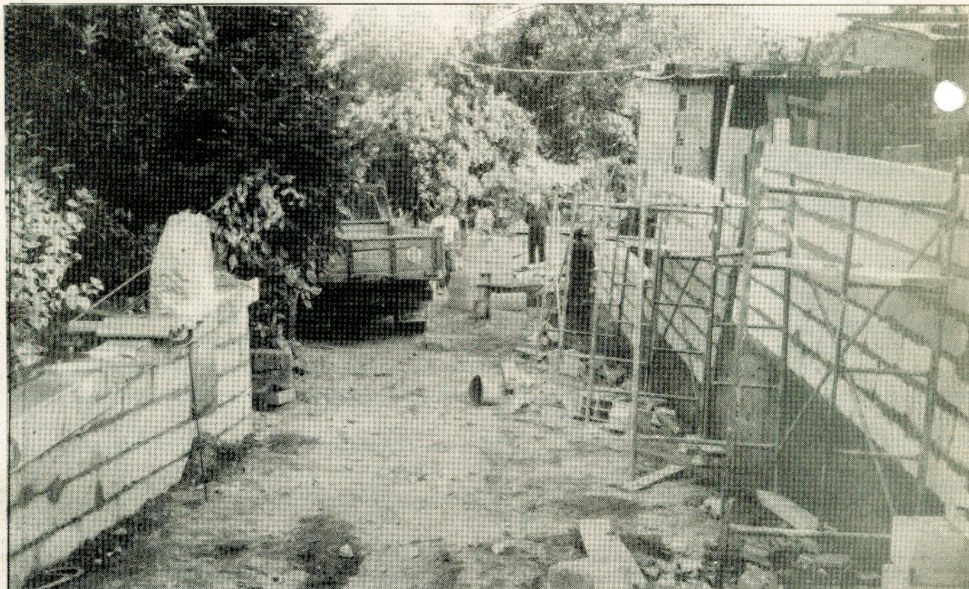
Póvoa do Meio (Vila) — Abertura de Caminho.
