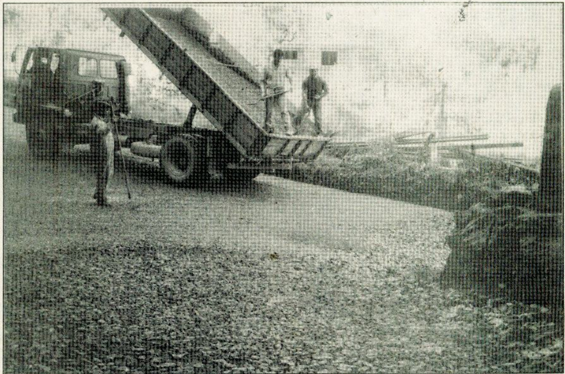
Caminho do Margido (Cedrim) - pavimentação.
