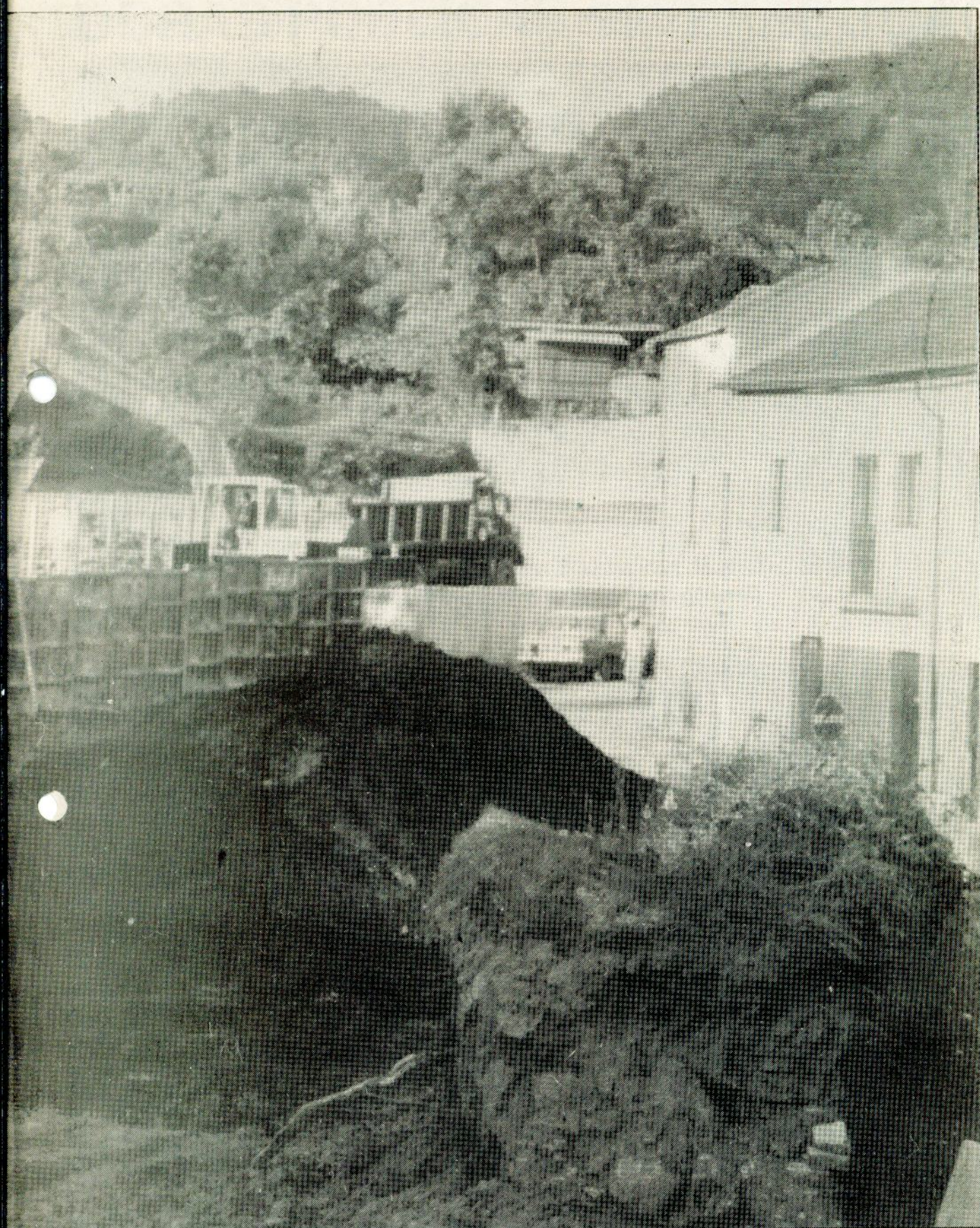
Managens e construção de muros.
