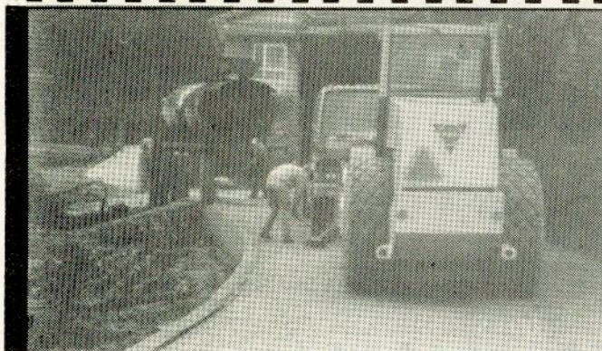
Caminho da Arcela — Pavimentação
