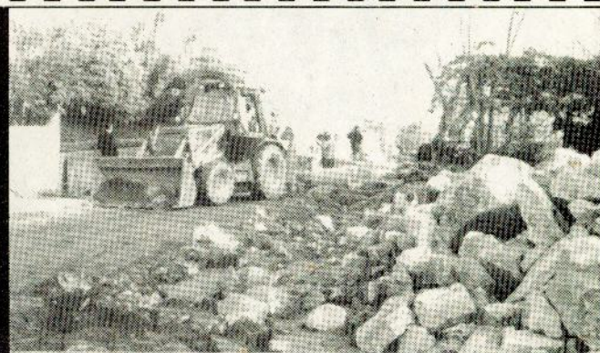
Caminho do Cruzeiro ao Mosqueiro. Abertura e colocação de rede de águas.
