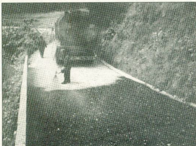
Caminho de acesso aos Sequeiros — Pavimentação
