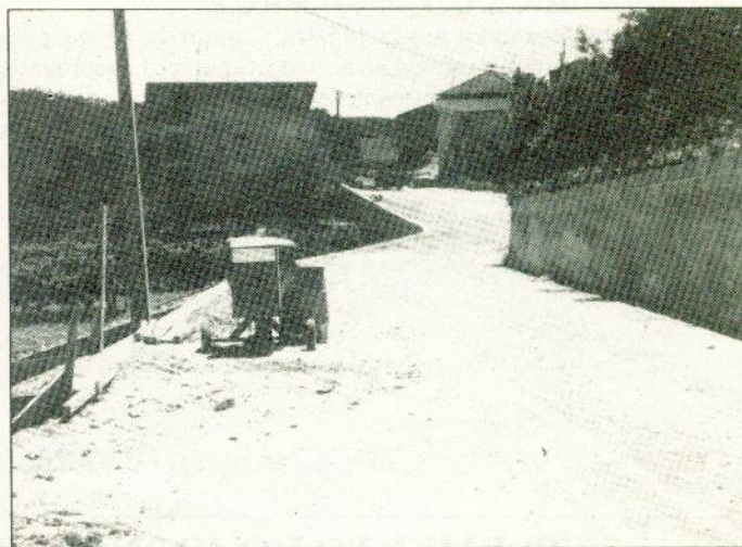
Estrada Municipal do Cruzeiro ao Mosqueiro — alargamento, beneficiação e colocação da rede de abastecimento de água.
