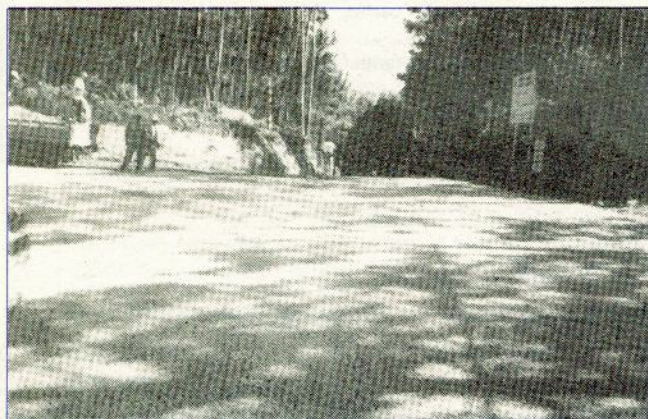
Pavimentação da estrada de Rio Bom - Dornelas.
