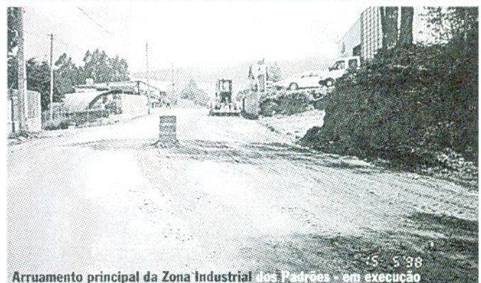
Arruamento principal da Zona Industrial dos Padroes - em execução
