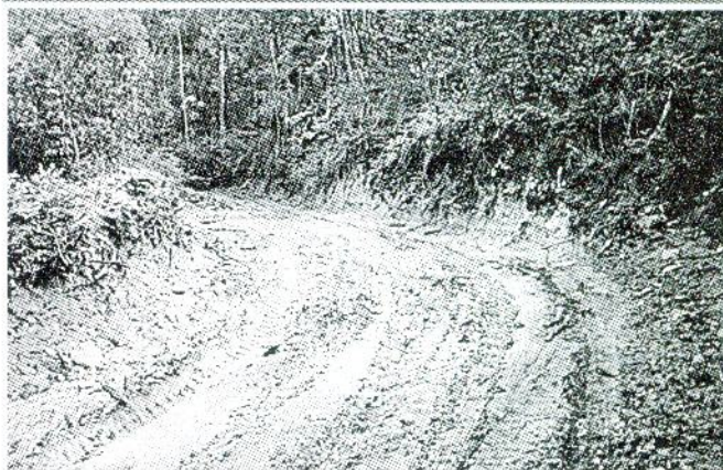
Alargamento e abertura de caminho florestal Boloalvo - Romezal
