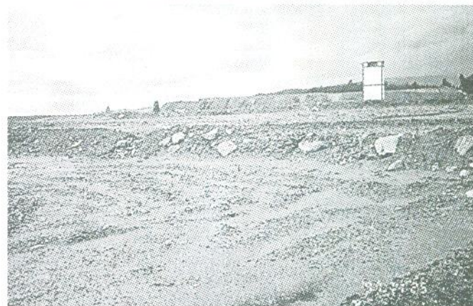
Zona Industrial de Cedrim - Concluído o movimento de terras - Vários lotes já adjudicados a futuras empresas
