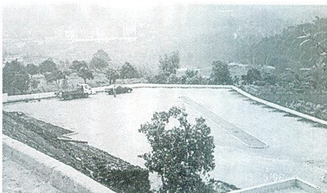
Centro Social Pessegueiro - Arranjos exteriores
