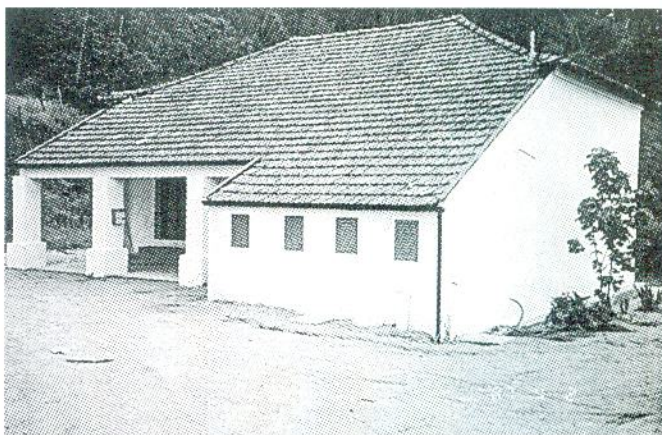
Arranjo geral e pintura da Escola de Paçô - Cedrim
