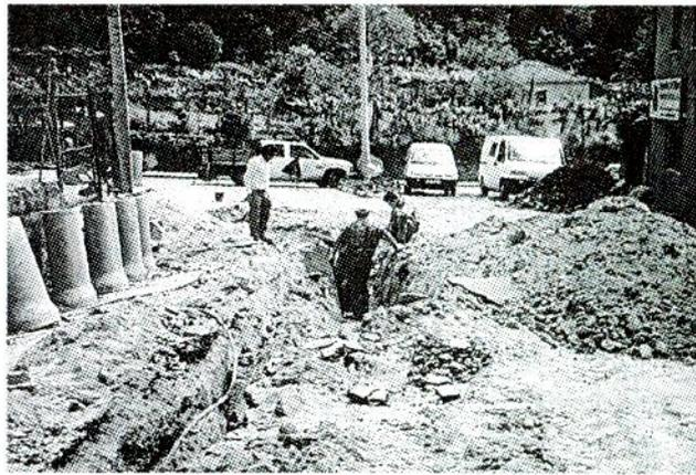
E.M. 554 troço da E.N. 328 à Senhorinha - Em execução com a colocação de colector de águas pluviais.
